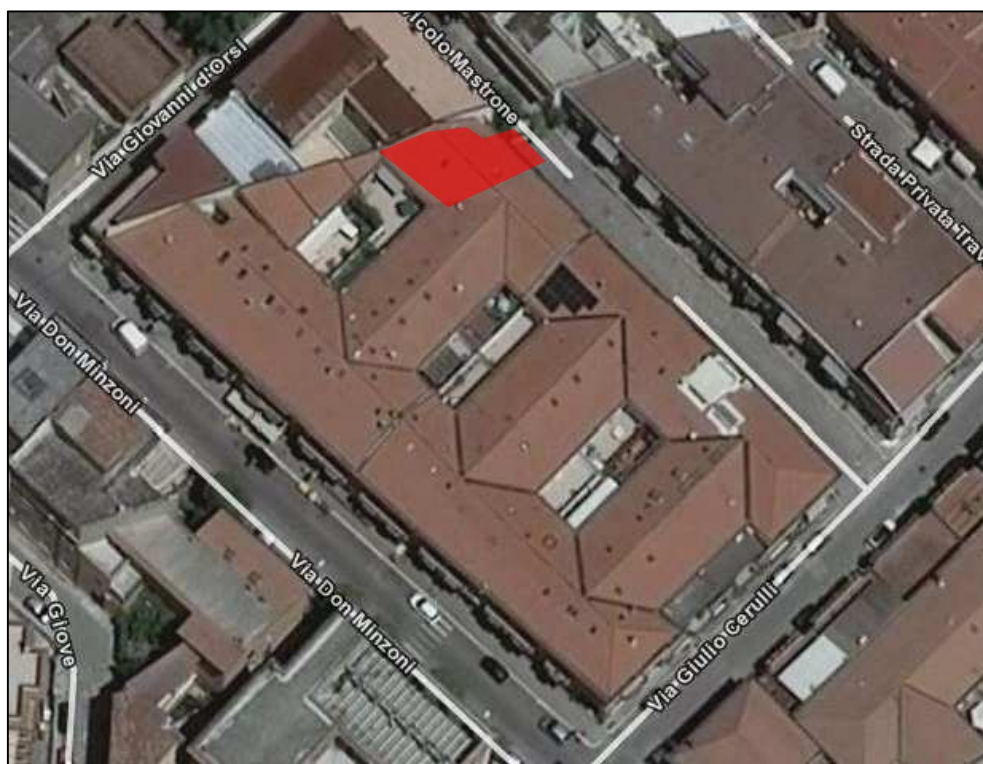
Foto 1 – Vista in ortofoto del fabbricato con individuazione dell'unità pignorata
