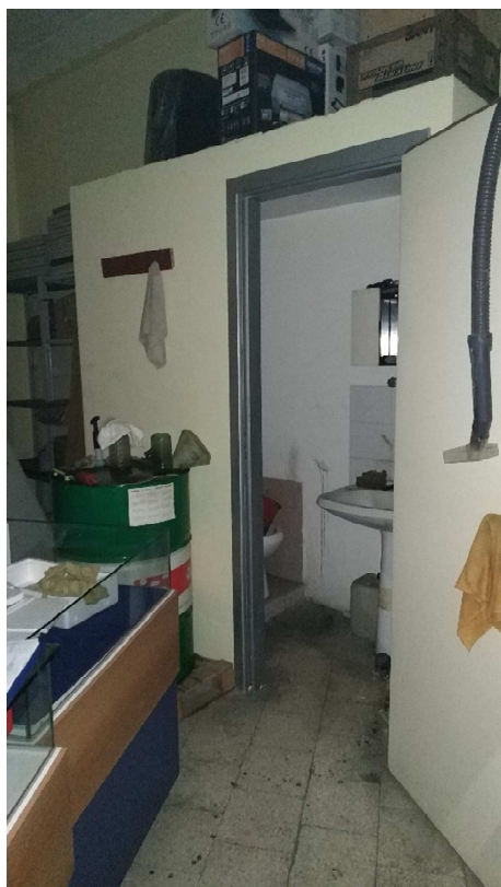
Foto 2 – Servizio igienico interno
